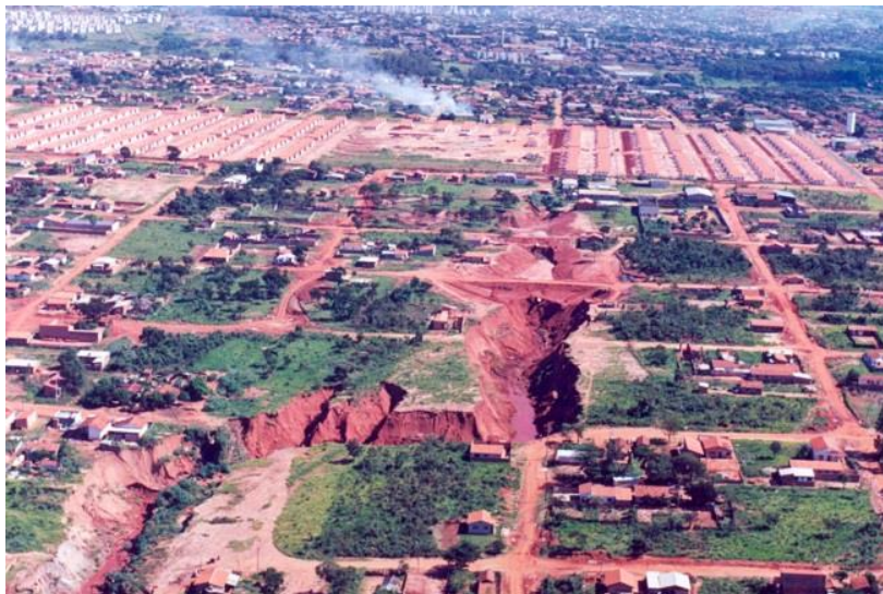
Figura 6. Boçoroca de grande porte localizada em área urbana.
