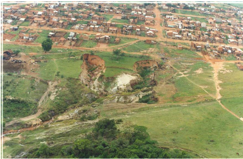
Figura 9. Boçorocas ramificadas em cabeceira de drenagem em área de expansão urbana.
